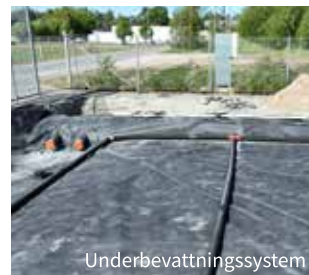
Schaktning för markbädd
